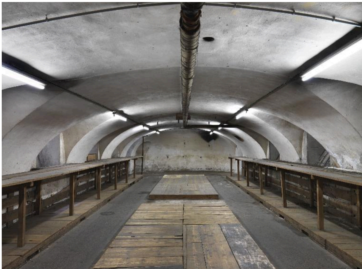
Vue d'ensemble des espaces du sous-sol.
