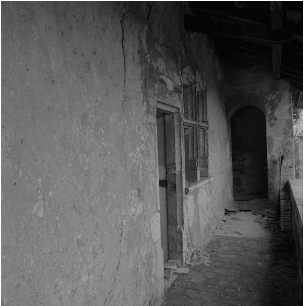
Etage en surcroît côté nord, galerie haute : porte et fenêtre à croisée moulurées.
