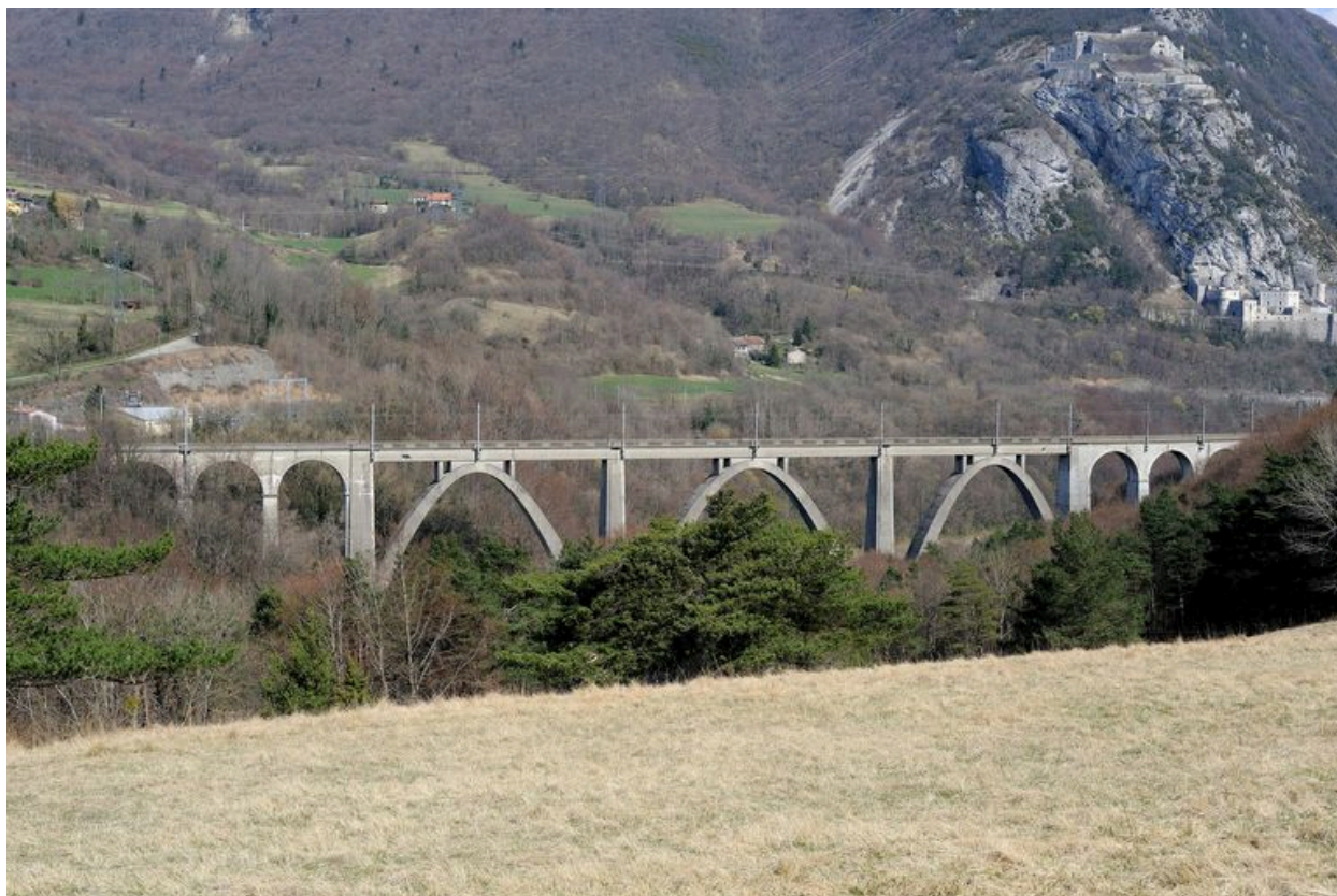
Vue du viaduc dans le site, côté aval
