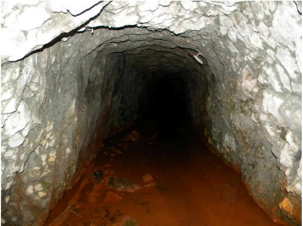
Vue de la galerie du travers-banc.
