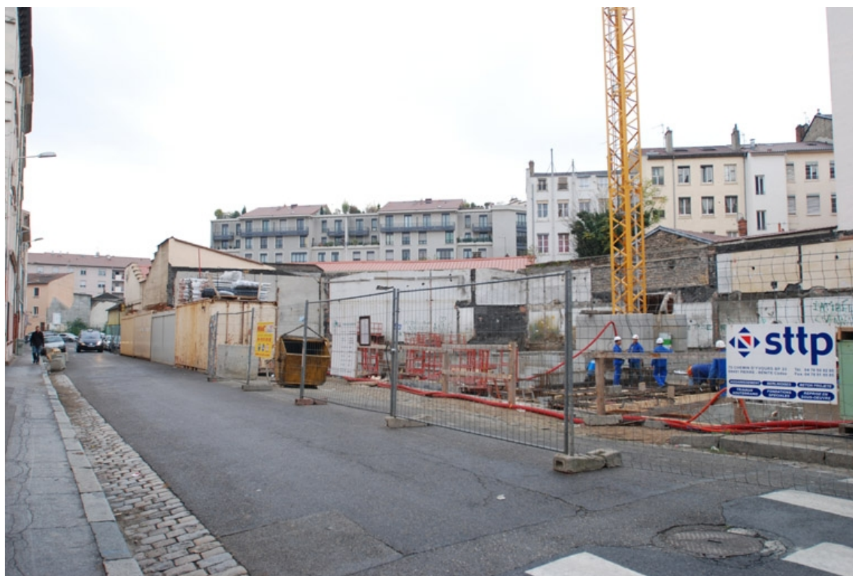
Vue nord, vue arrière du site
