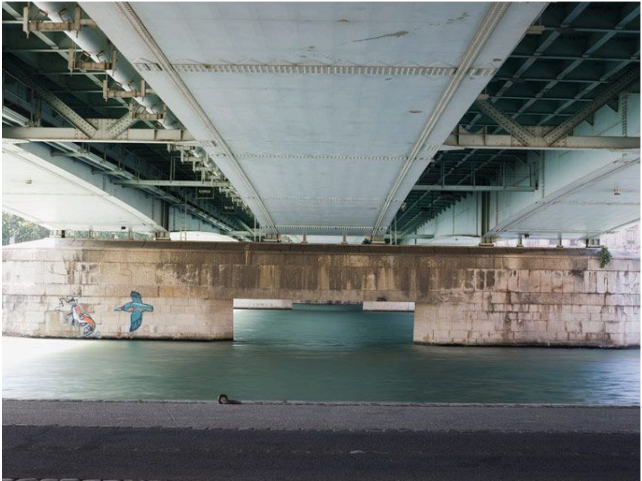
Détail des piles depuis le quai bas, rive gauche
