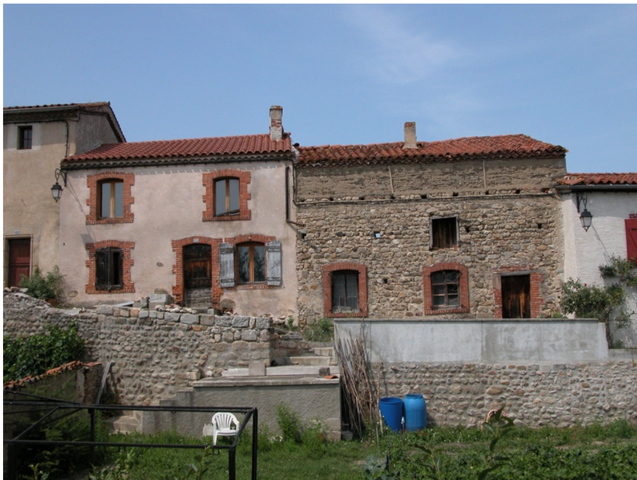
Le Bourg, rue de l'Hospice/chemin des Efossés. Maisons, ferme (1999 AD 171). Façades sur le chemin des Efossés.
