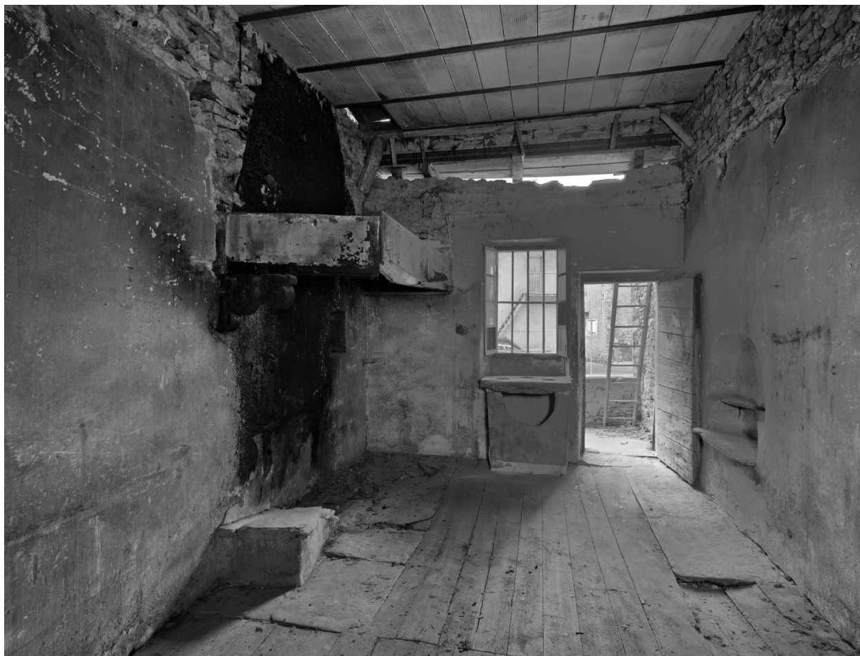
Vue intérieure de la cuisine B.
