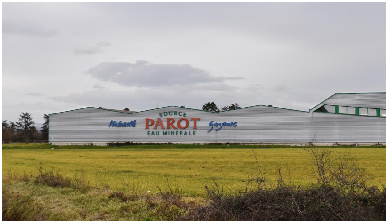
Façade principale enseigne
