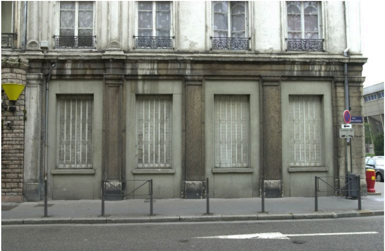
Rez-de-chaussée, rue Casimir-Perier
