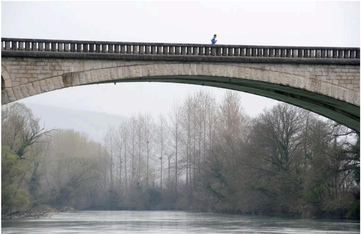
Vue partielle du tablier (face aval)
