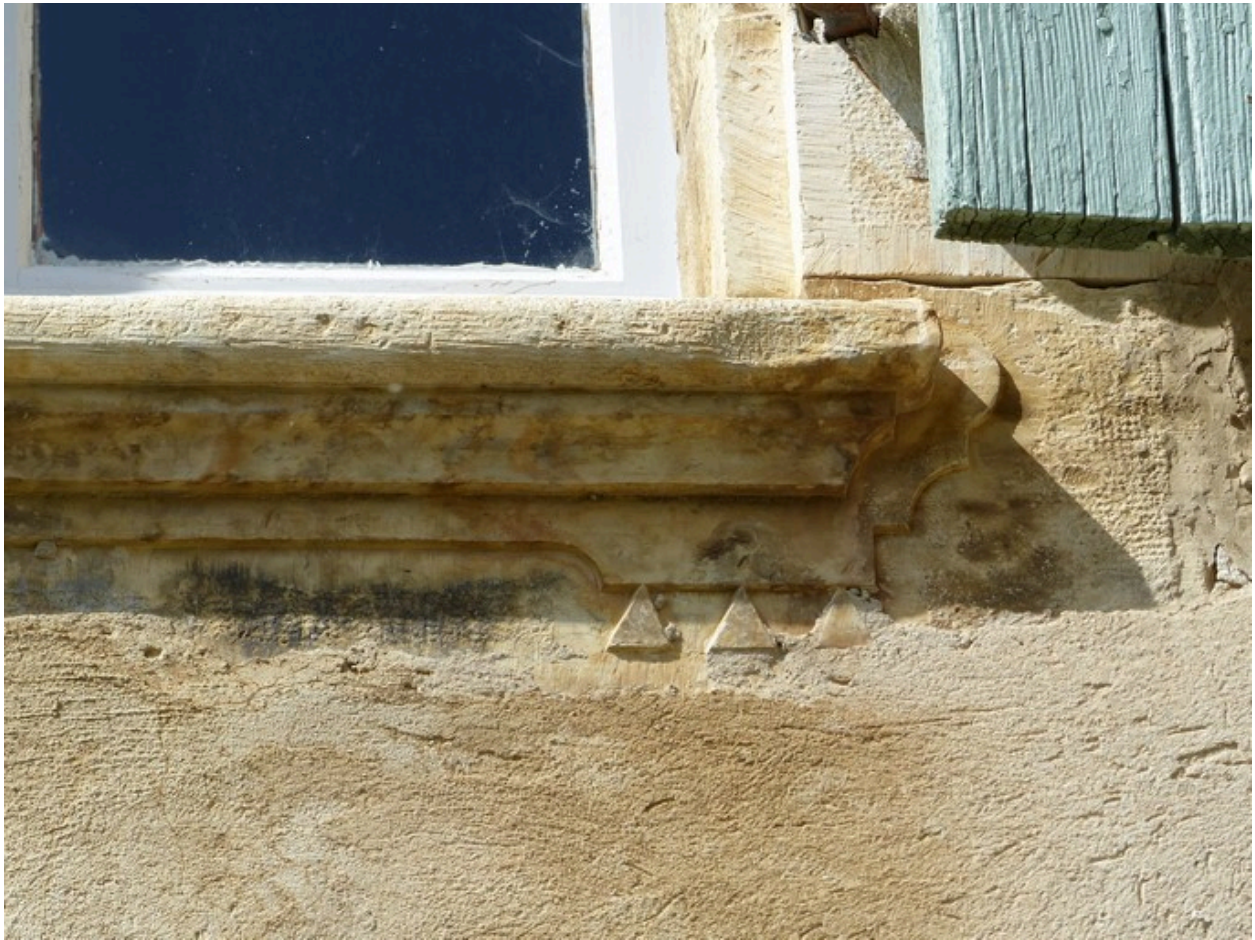
Bâtiment principal. Elévation sud, deuxième niveau. Fenêtre centrale, détail de l'appui.
