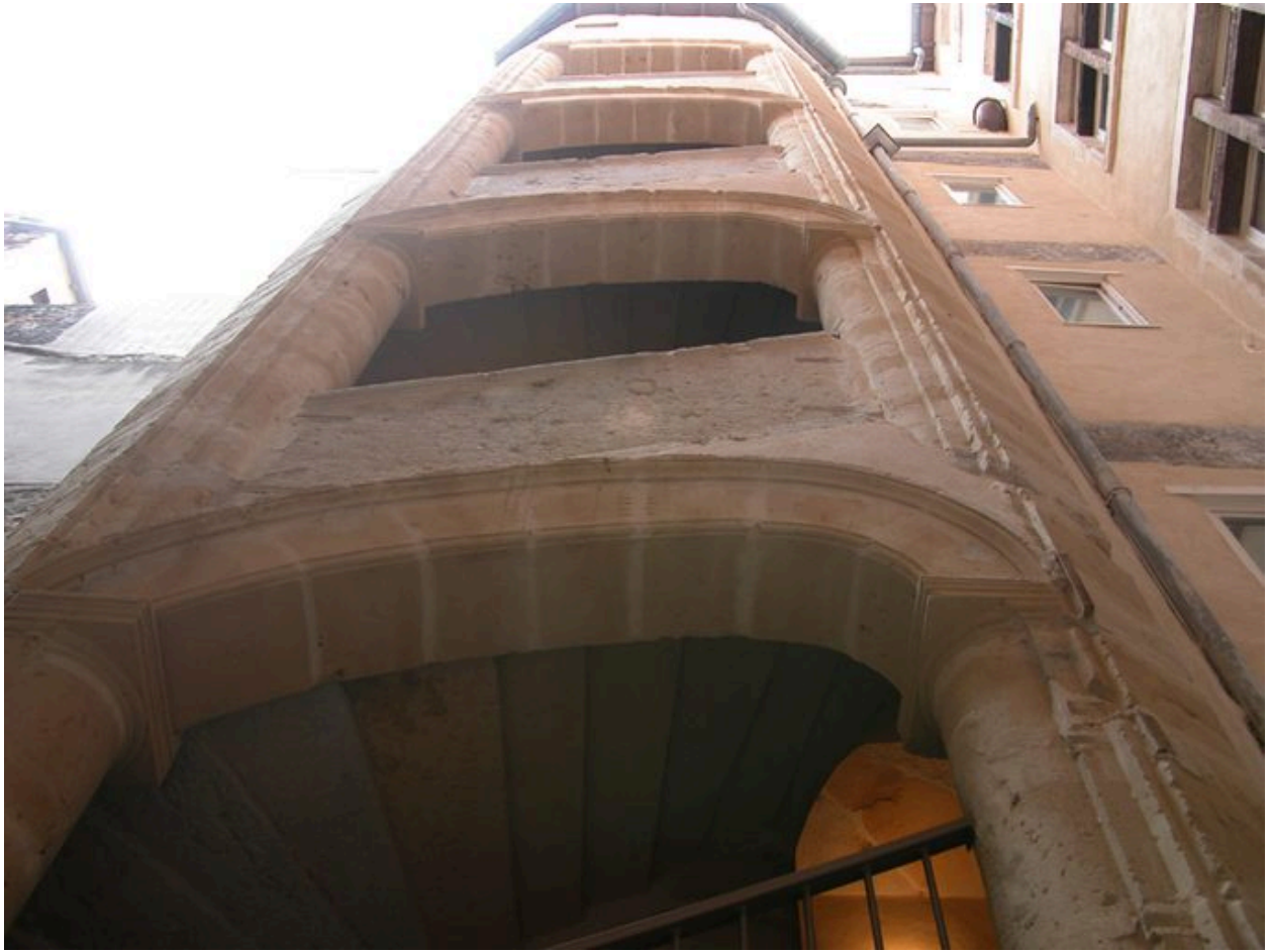
La cage d'escalier depuis la cour
