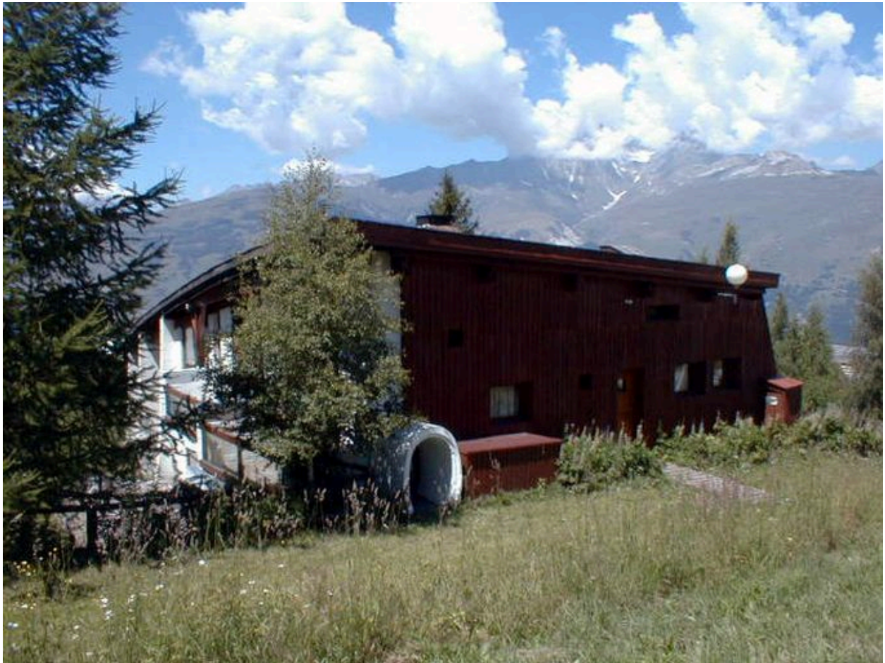
Façade est : pignon amont
