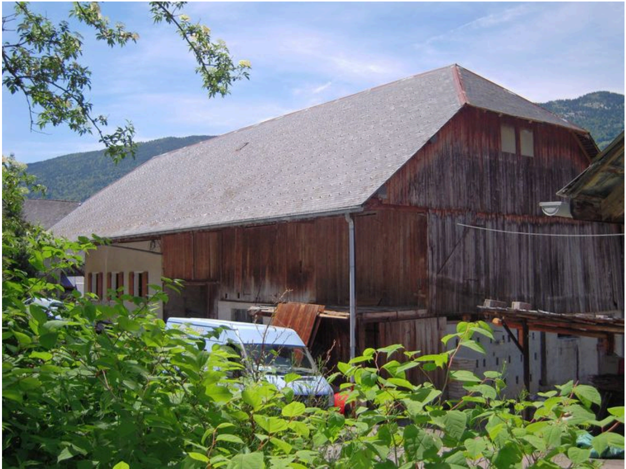
Vue d'une ancienne ferme réaménagée en atelier industriel.
