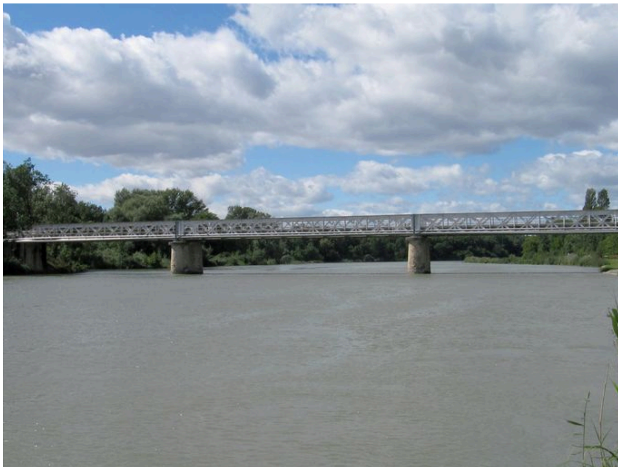
Vue générale, face amont (depuis la rive droite)
