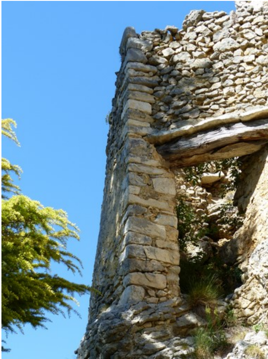
Extrémité du mur ouest.
