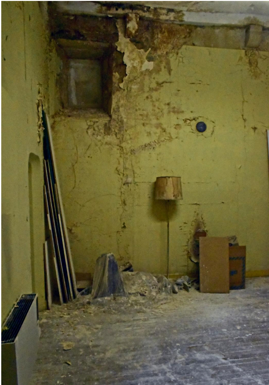
1er étage, salle nord-est : corbeau et ancienne baie murée
