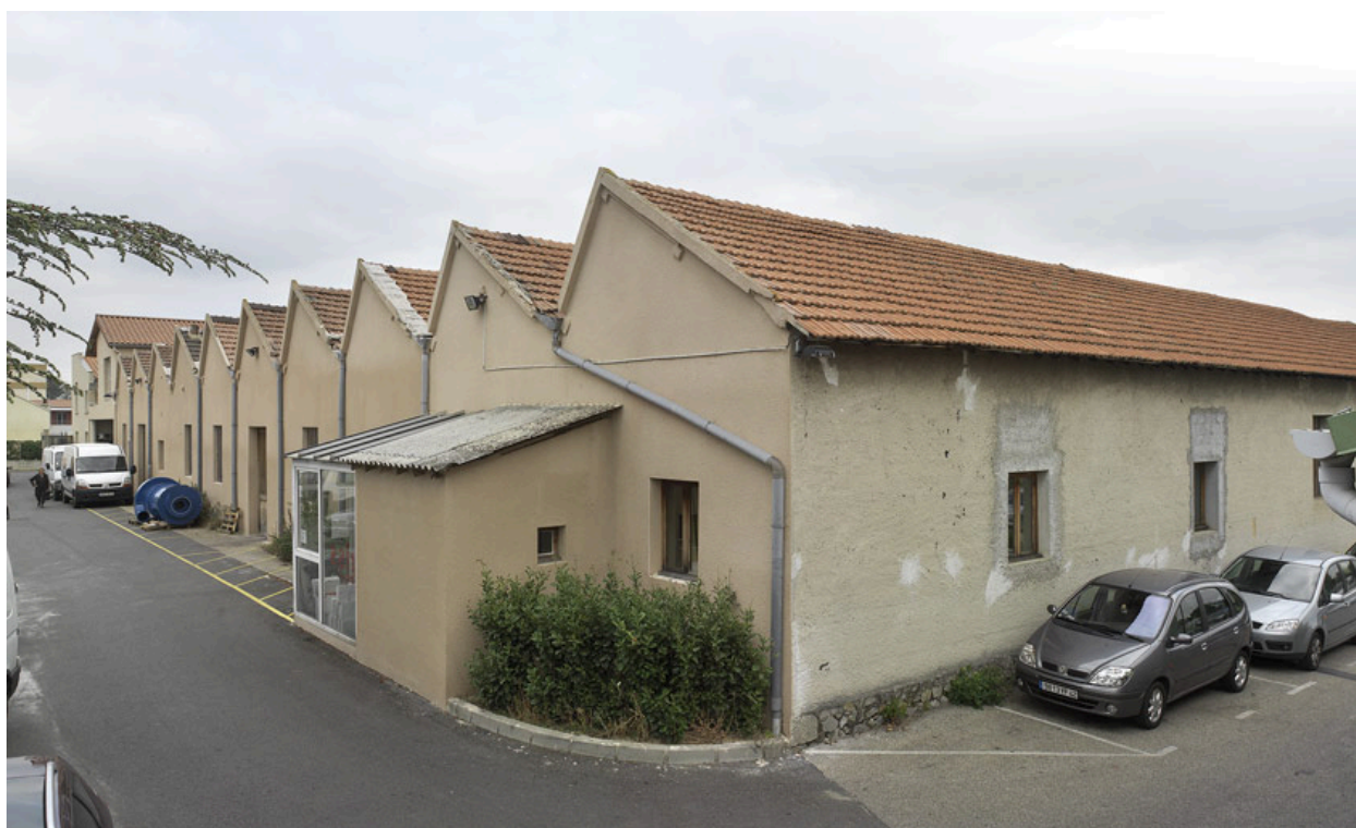
Usines construites par Claude Nourrisson au 4 impasse des Deux Avenues.
