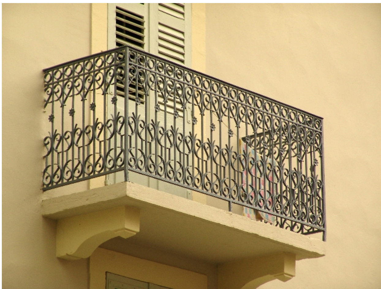
Détail d'un balcon
