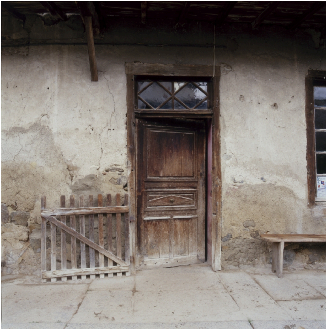
Elévation antérieure du logis, détail de la porte d'entrée.
