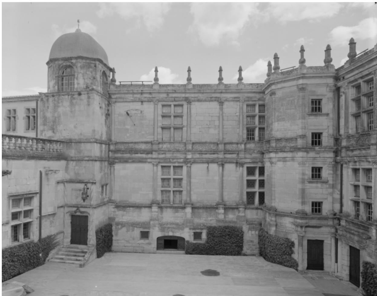
Cour du puits. Façade est. Vue générale
