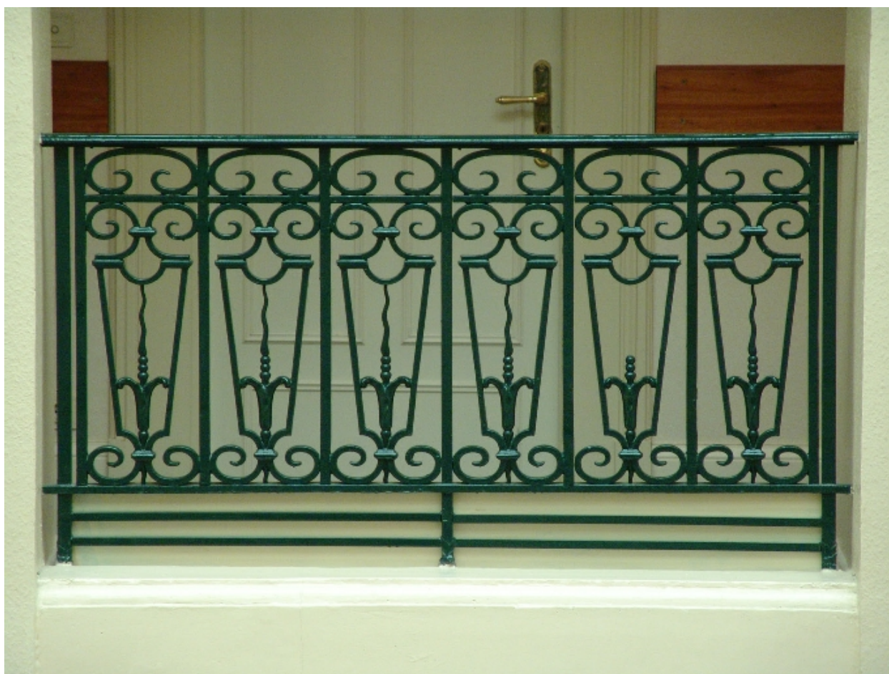
Atrium : garde-corps du 5e étage
