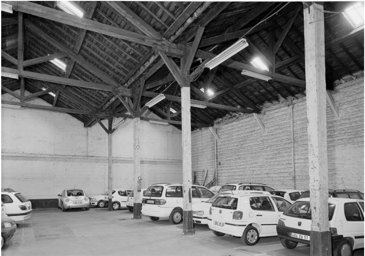
Vue du hangar nord-est depuis le sud
