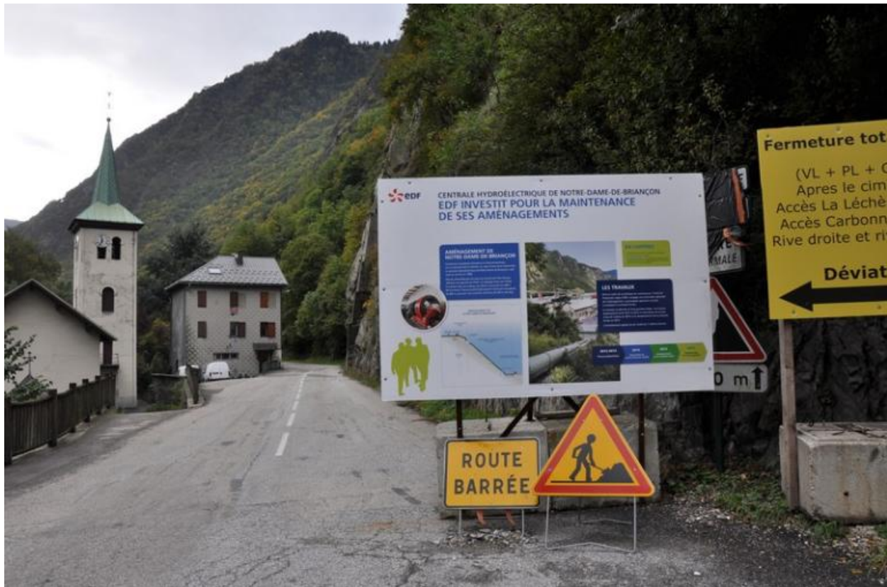
Route fermée en raison des travaux menés sur la conduite forcée de la centrale de Notre-Dame-de-Briançon, 2016.
