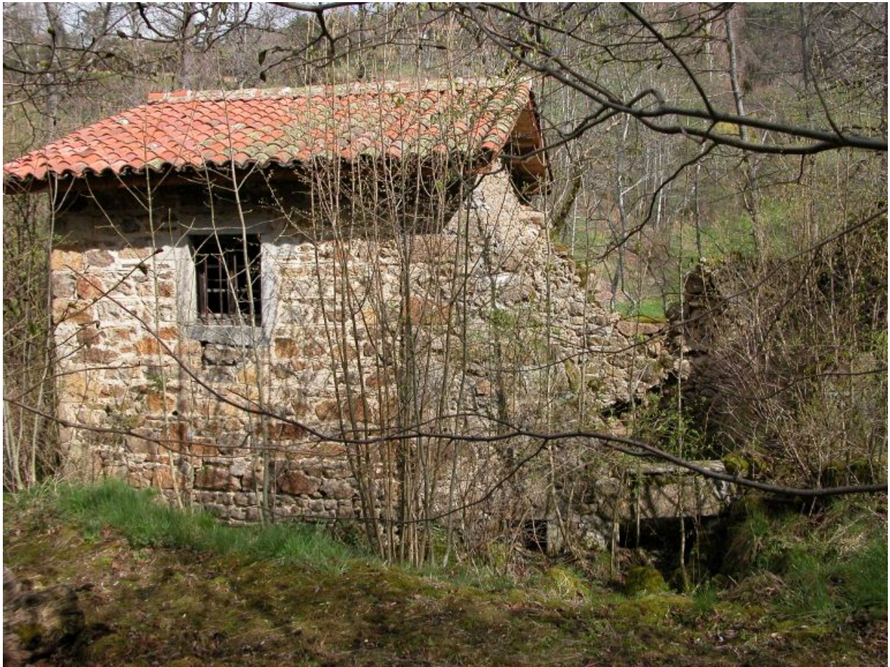
Vue partielle de la façade sud du moulin.
