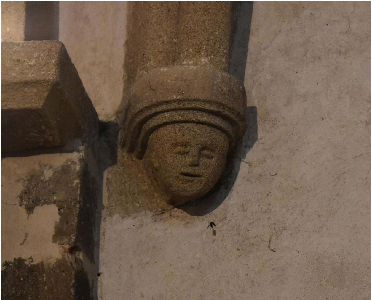
Culot à la retombée d'une ogive (angle nord-ouest de la seconde travée de la nef) sculpté d'une tête.
