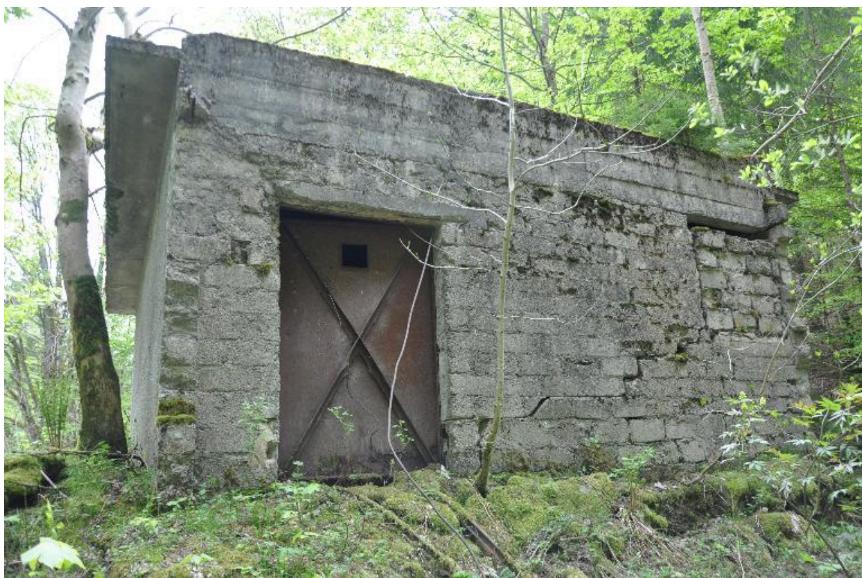
Façade postérieure du bâtiment attenant au barrage de la scierie
