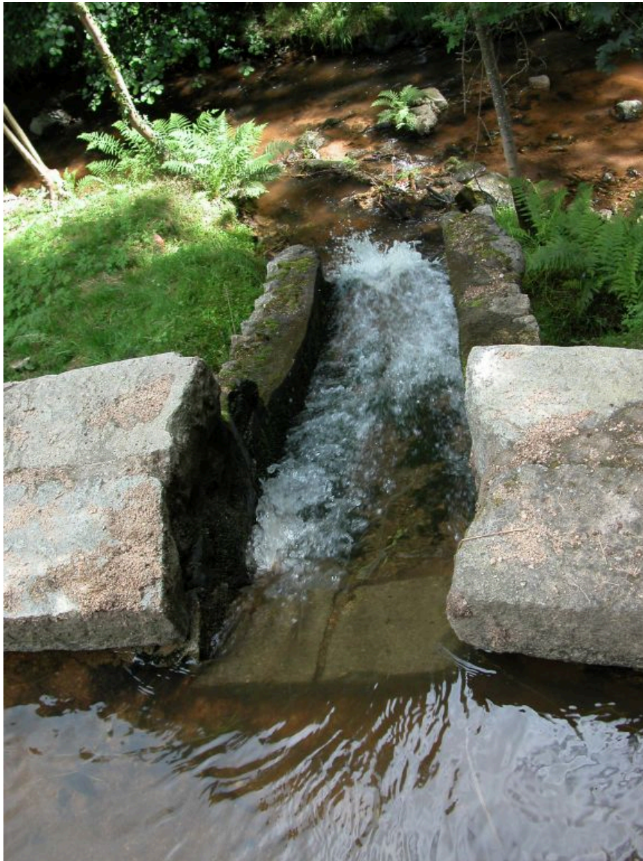
Ancien système de dérivation avec bassin. Ecoulement de l'eau hors du bassin.
