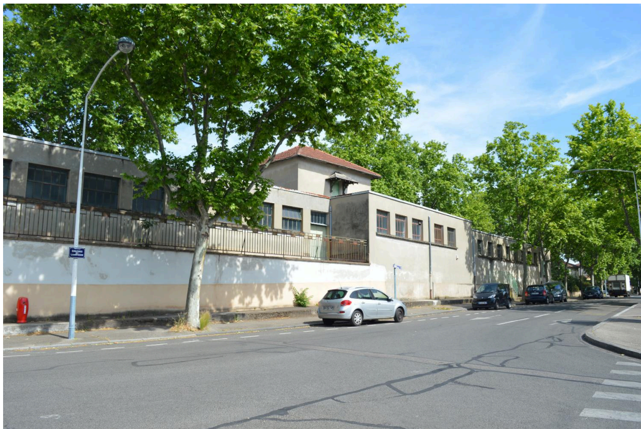
Vue des bains douches de Vénissieux façade arrière
