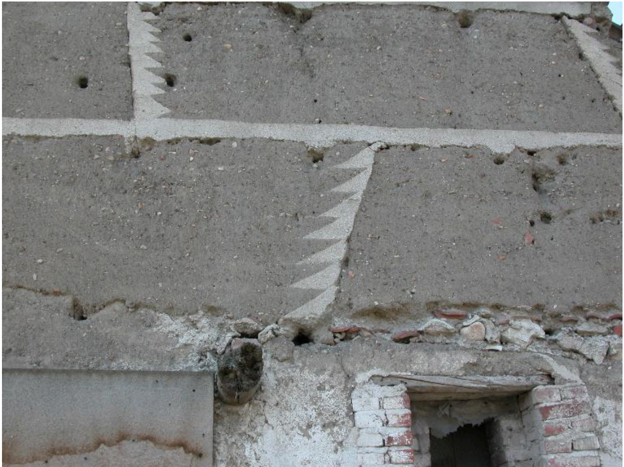
Bourg (le), Mur 1983 B1 719. Détail de mise en œuvre du mur de pisé sur un soubassement constitué de galets.
