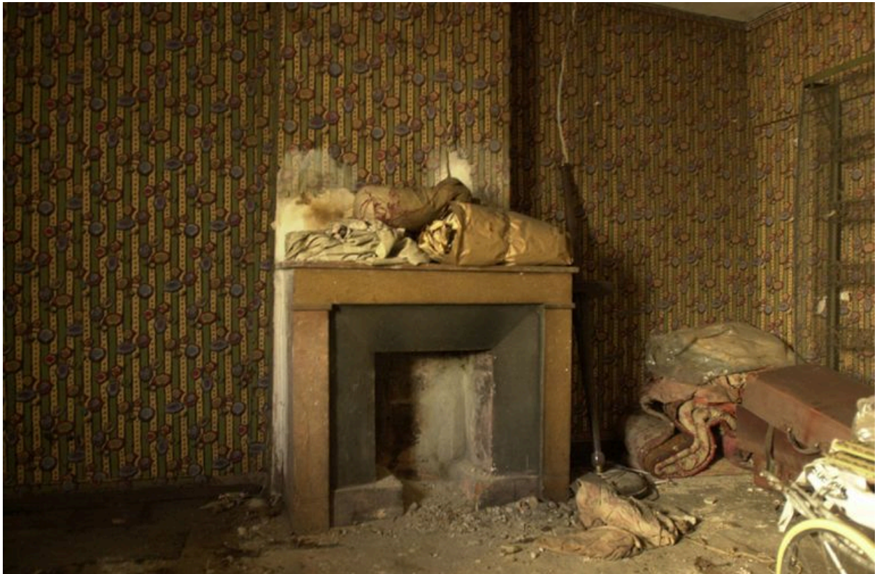
Cheminée de l'étage en surcroît
