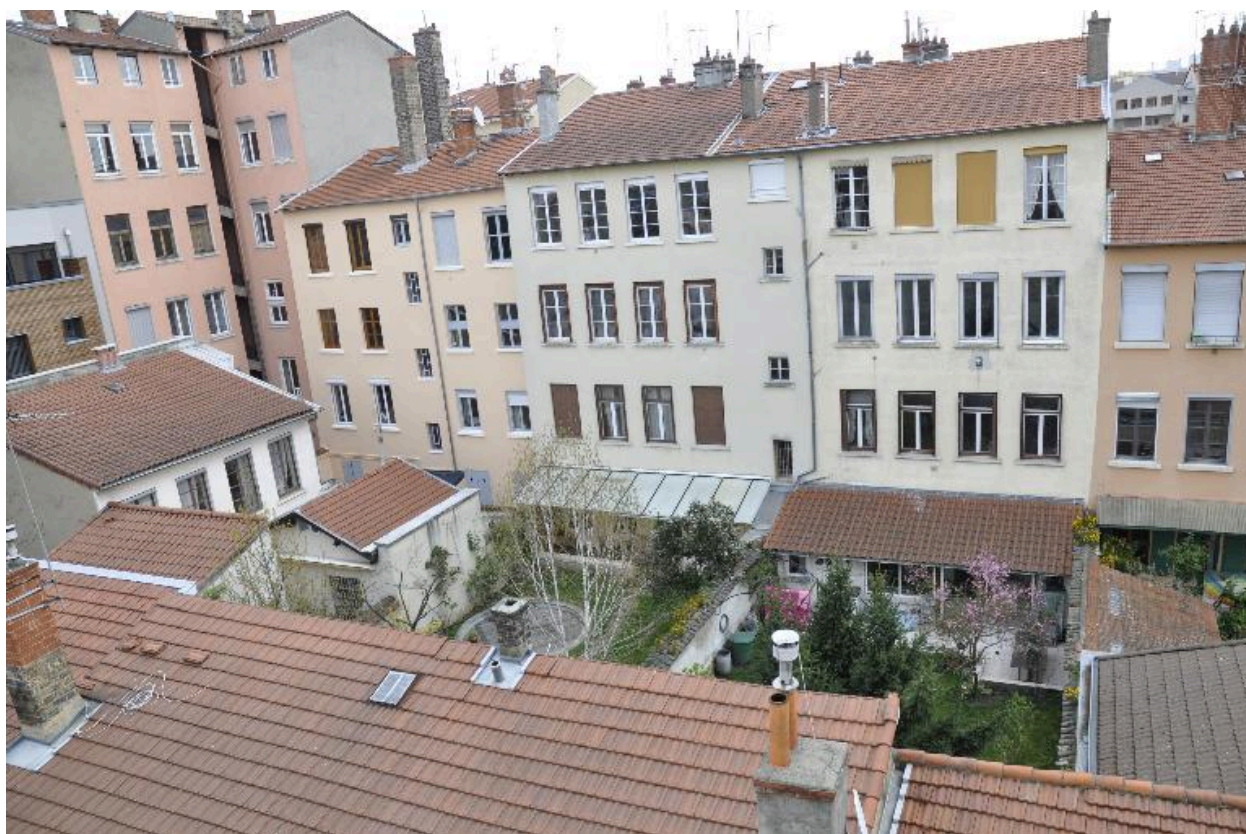
Vue d'ensemble ouest de l'immeuble de trois étages sur cour
