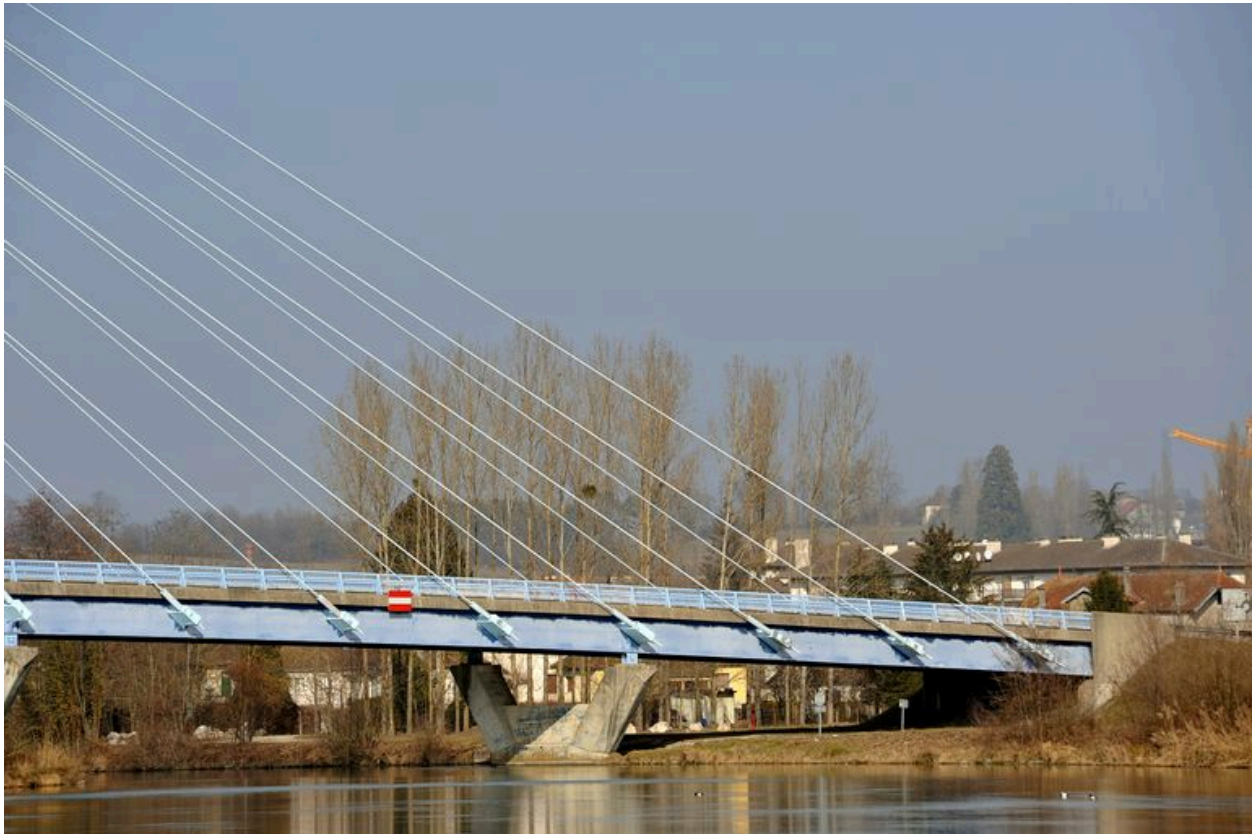
Vue partielle, travée gauche, face aval (depuis la rive droite)
