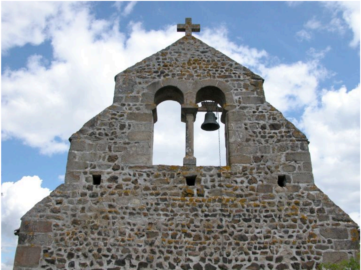
Détail de la partie haute du clocher-mur.
