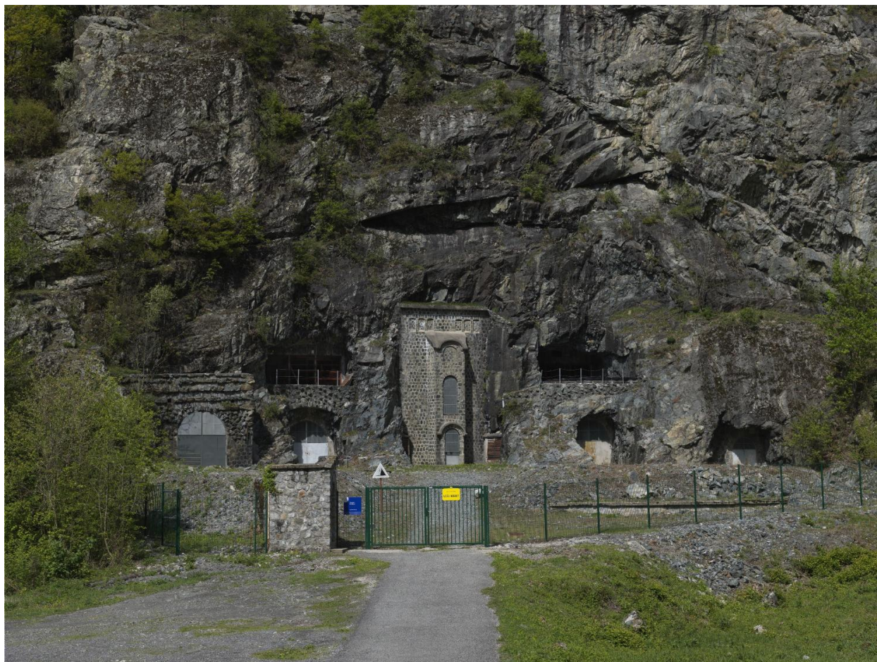
Vue d'ensemble de la centrale de Bâton
