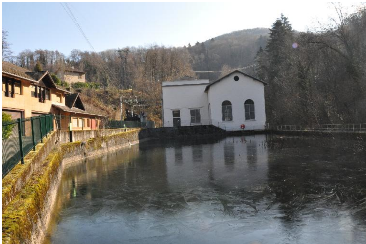
Vue de la centrale du Bens.
