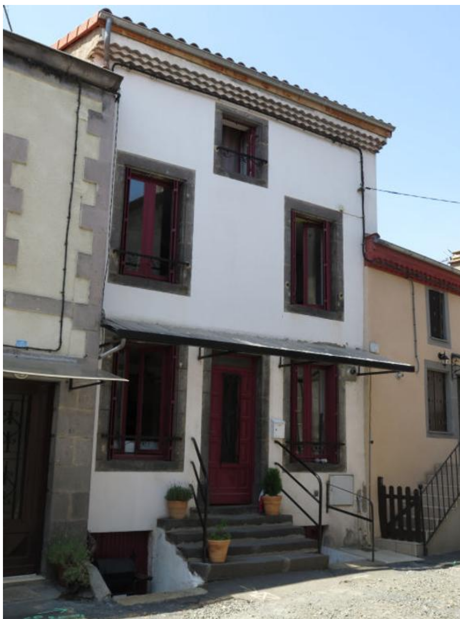
Edifice atypique (Le Cendre, 17 impasse de la Rue Froide)
