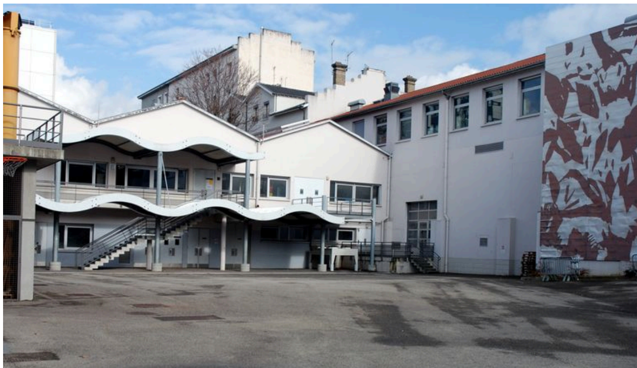
Bâtiments C et E : vue depuis le sud ouest
