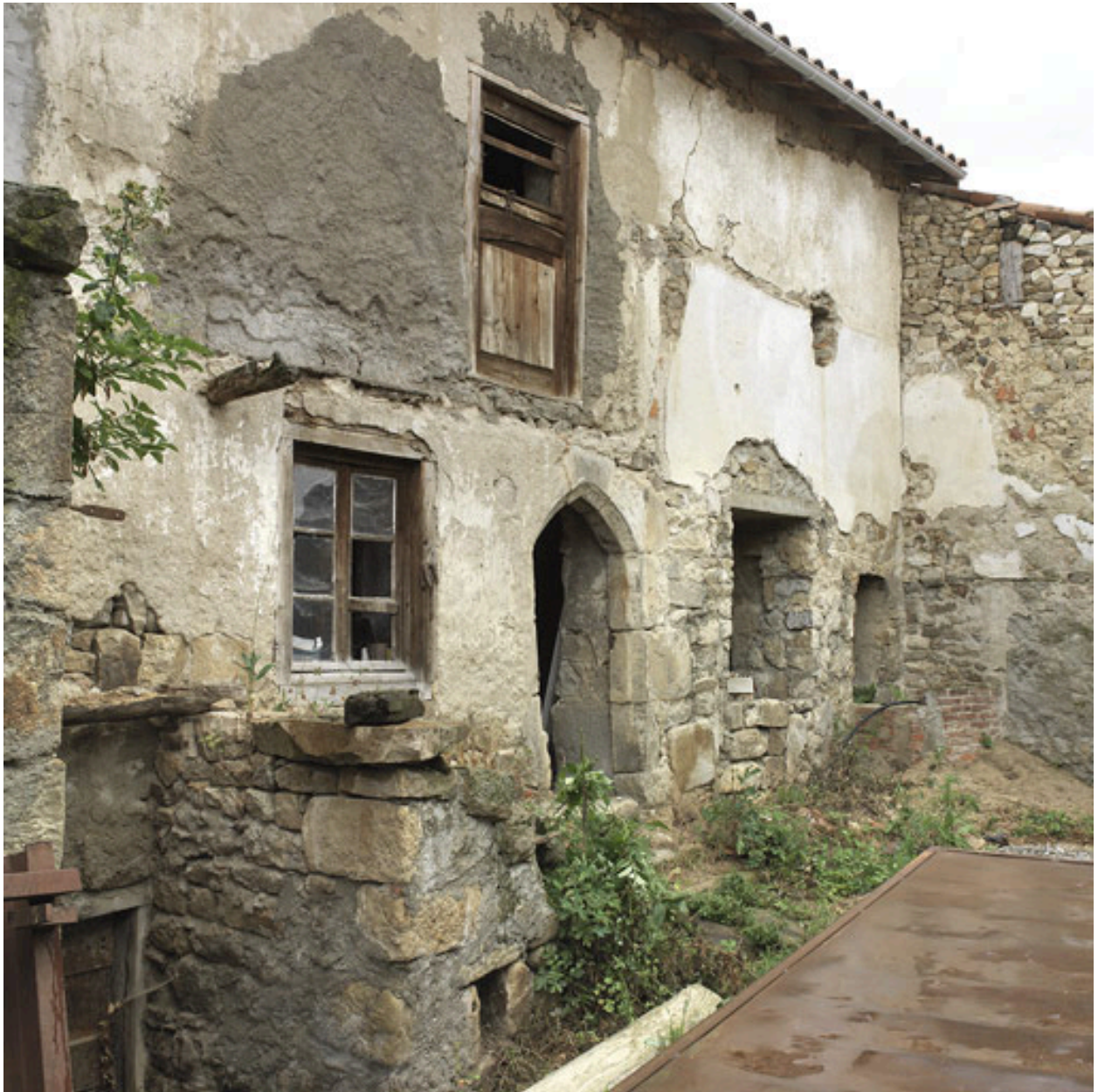
Vue d'ensemble du logis depuis le sud-est.
