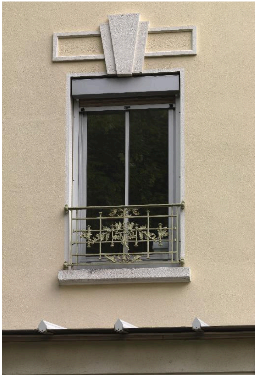
Elévation sud, détail d'une fenêtre
