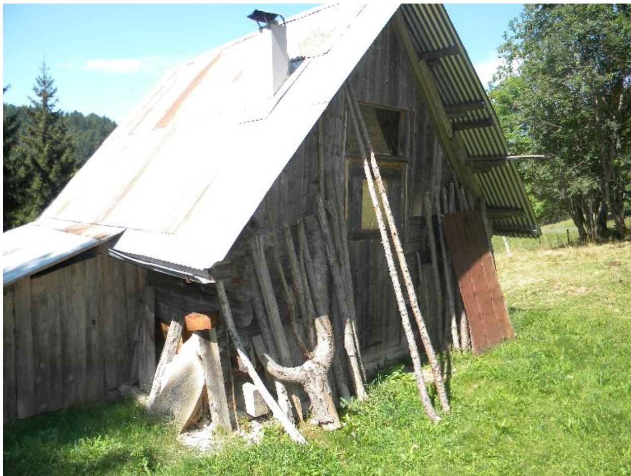
Vue de la façade arrière.
