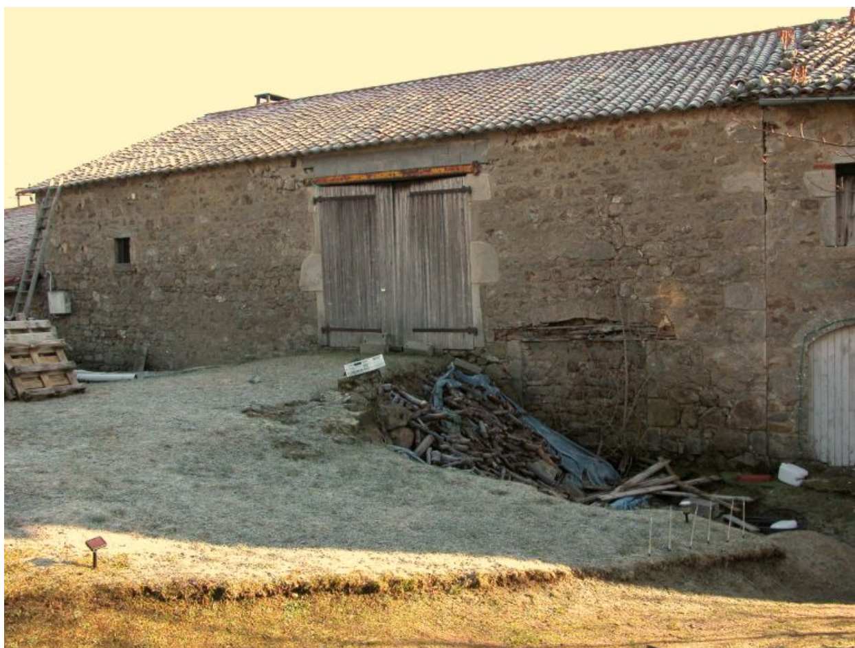
Vue d'ensemble arrière de la grange.
