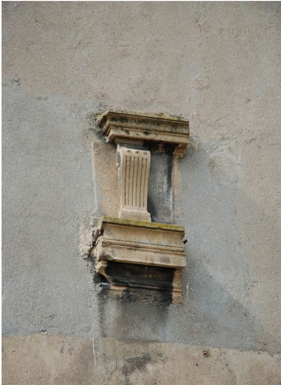
Détail de la façade latérale Ouest
