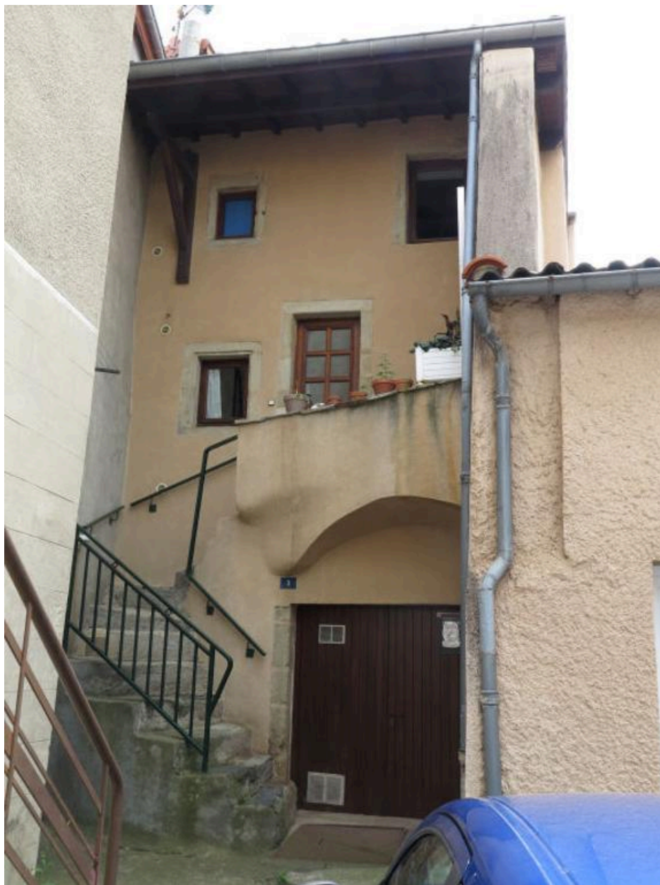
Édifice atypique (Romagnat, 3 rue des Allées)
