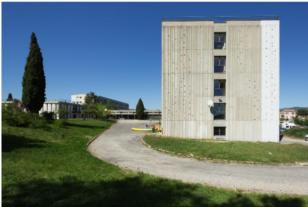
Bâtiment sud : pignon sud
