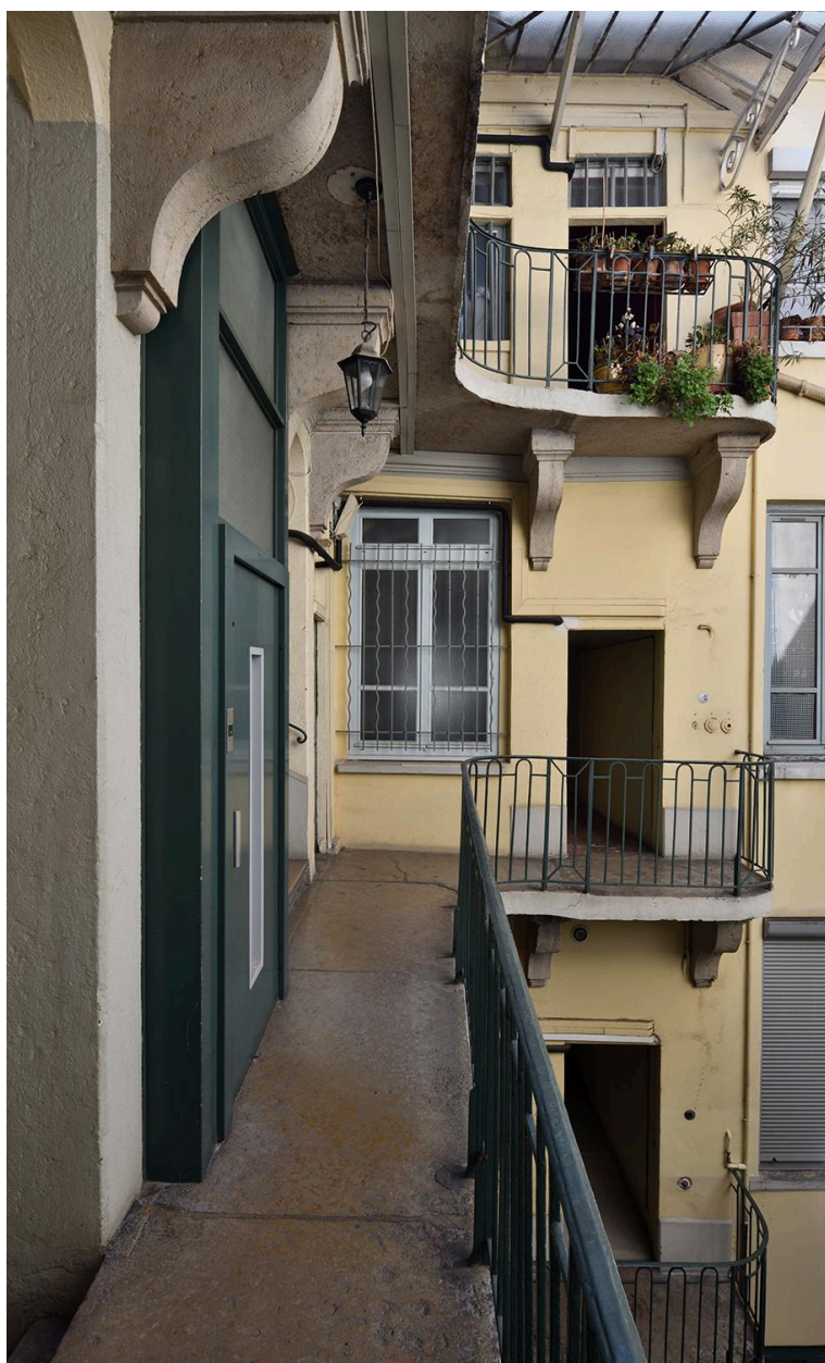
Galleries desservant les appartements
