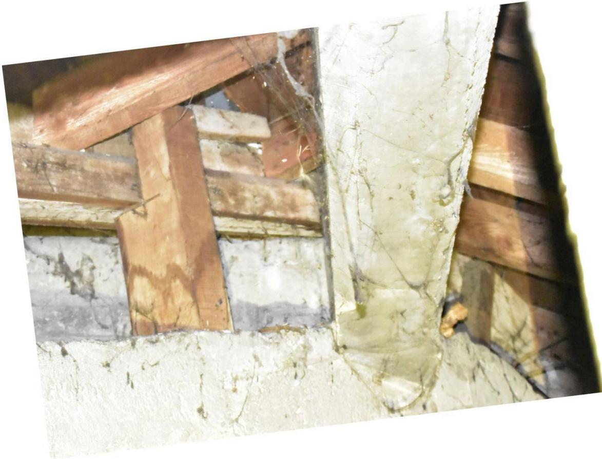
Charpente de toit en béton, faîtage : gros plan sur un chanfrein à congé (détail de modénature que l'on peut repérer à différents endroits dans l'établissement).
