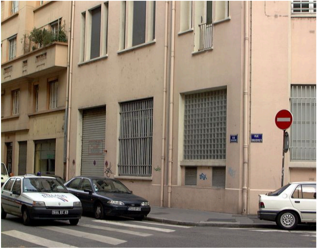
Détail des ouvertures du bas de la façade rue Vendôme
