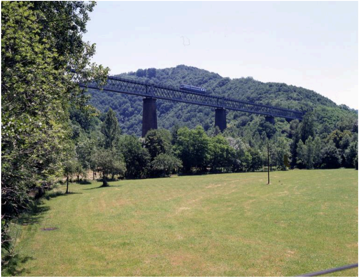
Vue du viaduc de la Sumène lors du passage de l'un des derniers trains de voyageurs, en 1994.
